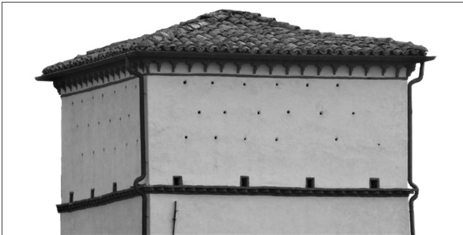
Fig. 2 – Una “colombaja a rondoni” o meglio “torre rondonara” (Appennino modenese) coeva delle attività di studio di Lazzaro Spallanzani. Oltre ai fori di ingresso per i colombi sulla cornice del marcapiano, sono riconoscibili i fori di accesso per i rondoni, su tre file; in totale 18 celle per lato (foto M. Ferri).
