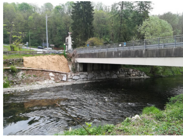
Figura 50 - Mensola per passaggio faunistico, realizzata appoggiandosi al piede di un ponte di una strada provinciale (Lonate Ceppino, VA).
