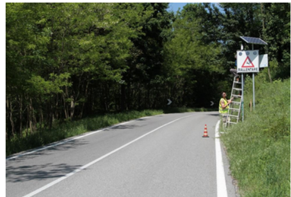
Figura 53 - Segnale luminoso che avvisa l'automobilista della possibile presenza di fauna selvatica sulla carreggiata.
