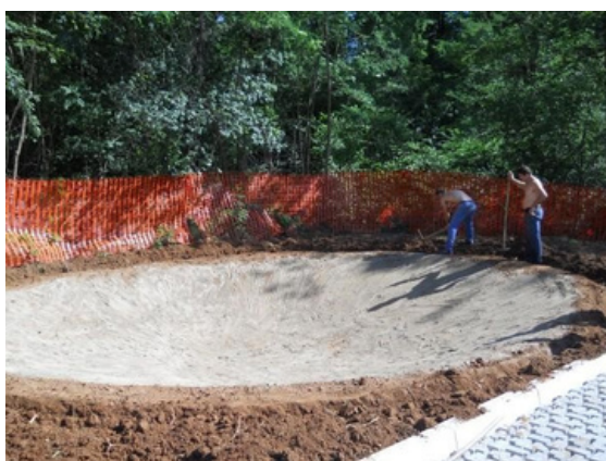
Figura 35 - Esempio di preparazione del fondo di un laghetto artificiale di 8 m di diametro con margini poco acclivi.
