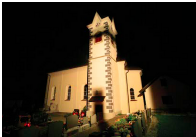
Figura 22 - Chiesa con accessi dei chiroterri al sito oscurati.
