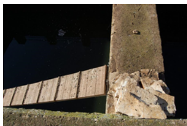
Figura 32 - Rampa di risalita per animali nella cisterna "antica San Magno" – Parco Nazionale dell'Alta Murgia.
