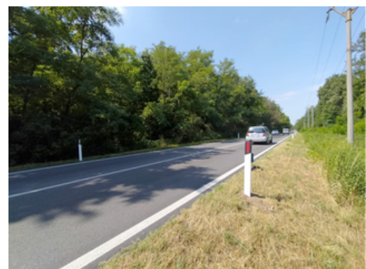
Figura 51 - Dissuasori ottici riflettenti (Cislago, VA).
