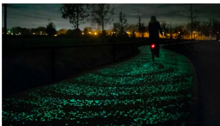
Figura 21 - Esempio di pista ciclabile costituita in materiale fotoluminescente.
