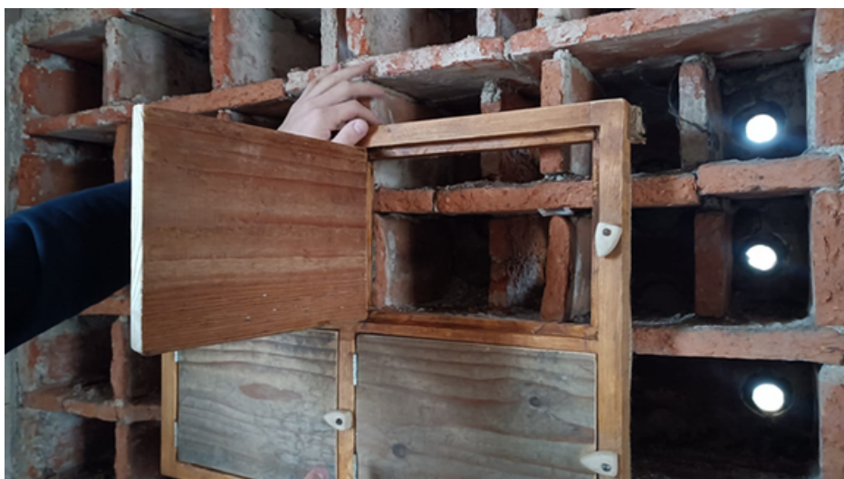
Figura 9 - Lavori di riqualificazione della torre rondonaia di Casa Macchi a Morazzone (VA), Bene FAI.
