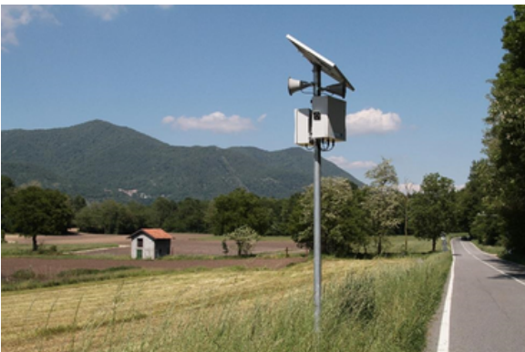
Figura 52 - Sistema che emette il segnale sonoro negli impianti anticollisione (Gemonio, VA).
