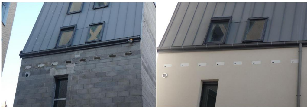
Figure 19 : Photographies de nichoirs intégrés dans un mur en parpaing sur un bâtiment de la ville de Rennes © Olivier Winock – Nath'H
