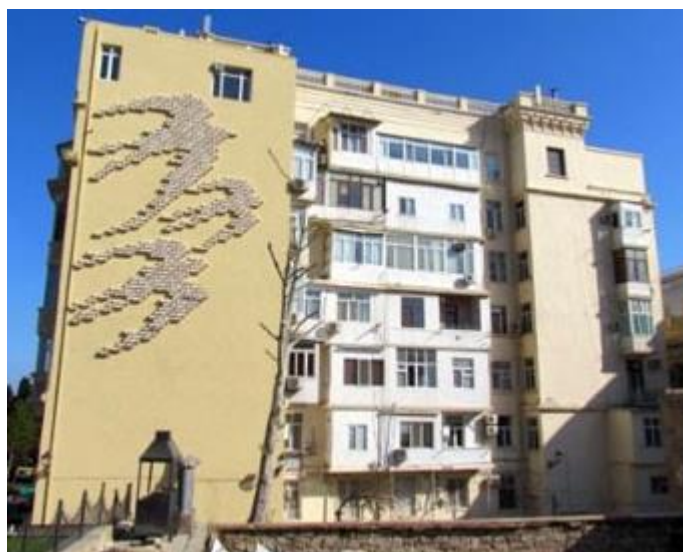
Figure 25 : Photographie de l'immeuble qui accueille les couples de martinets de la Tour Maiden grâce aux 500 nichoirs présent sur la façade © actionforswifts.
