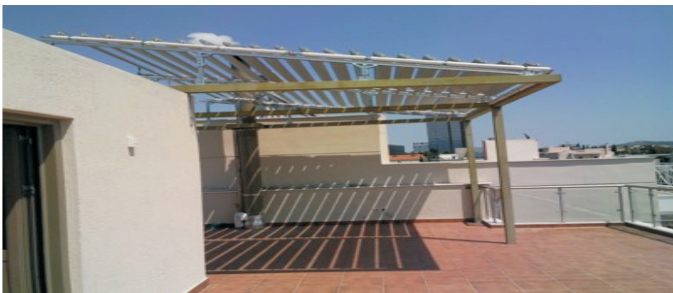
Εφαρμογή σε μορφή πέργκολα για ενδοδαπέδια θέρμανση, ζεστό νερό και πισίνα
