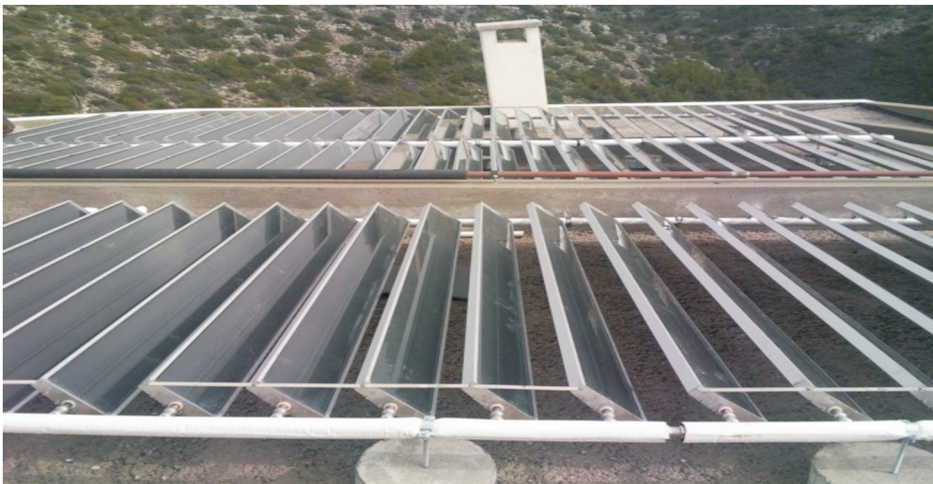
Εφαρμογή σε επίπεδη ταράτσα για ενδοδαπέδια θέρμανση, ζεστό νερό και πισίνα
